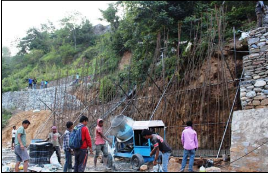
बेनी-दरवाङ सडकको मंगलाघाट खण्डमा सडक फराकीलो बनाउन ढलान र पर्खाल निर्माण गरिँदै ।
