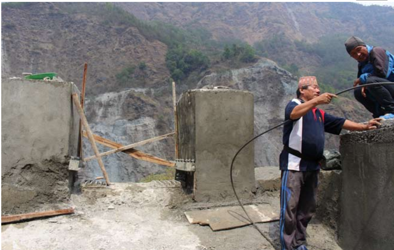
बेगखोला-बादुक जोड्ने पुल : म्याग्दीको रघुगंगा गाउँपालिका १ बेगखोला माथि बेग र बादुक गाउँ जोड्ने ३६५.८ मिटर लम्बाई भएको भोलुङ्गे पुलको बेगखोलातर्फको ब्लकमा काम गर्दै कामदार । यो पुल एलएसटीबी सिङ्गल स्पाम प्रविधिमा नेपालकै लामो हुने जिल्ला समन्वय समितिले जनाएको छ ।
