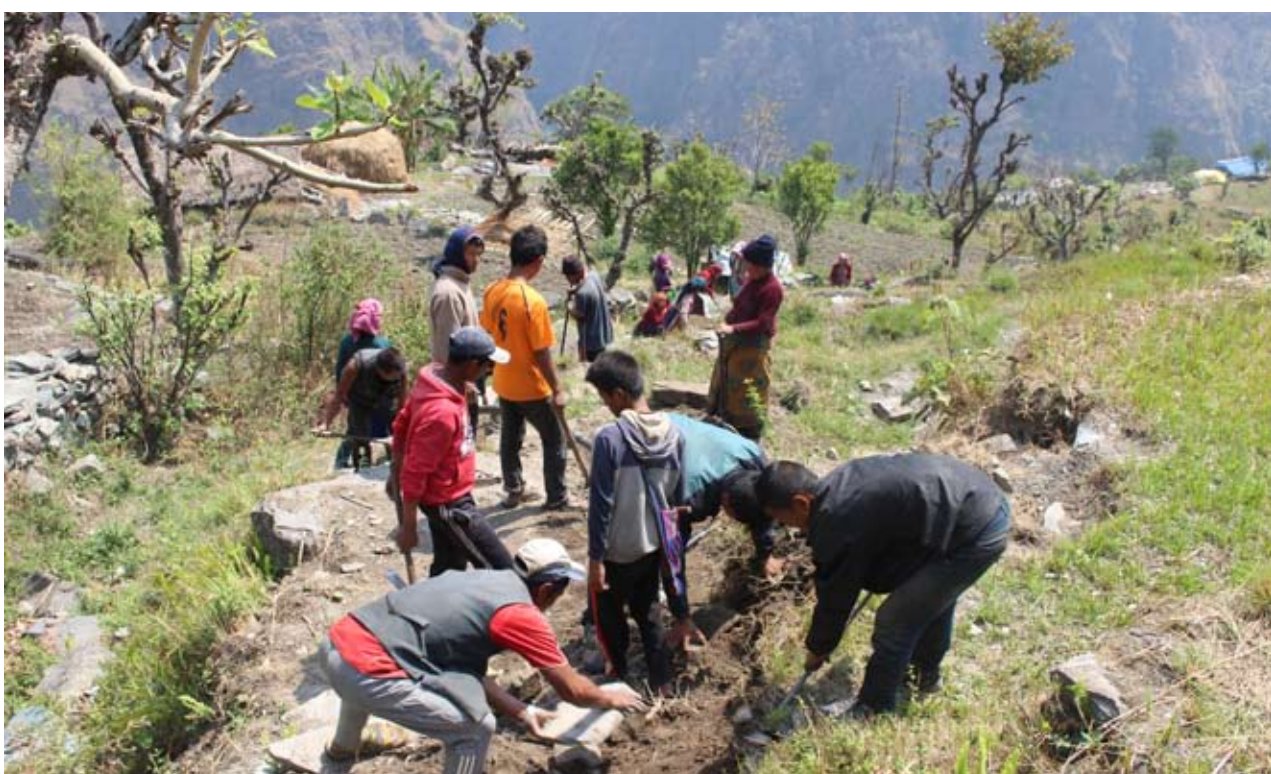
परिश्रमी जनता : रघुगंगा गाउँपालिका १ बेगको औलाका बासिन्दाहरू खानेपानी आयोजनाको वितरण पाईपलाईन निर्माणका लागि श्रमदान गर्दै । खानेपानी तथा सरसफाई सब डिभिजन कार्यालय म्याग्दीको सहयोगमा बृहत बेगखोला खानेपानी तथा सरसफाई निर्माणाधिन अवस्थामा रहेको छ ।
