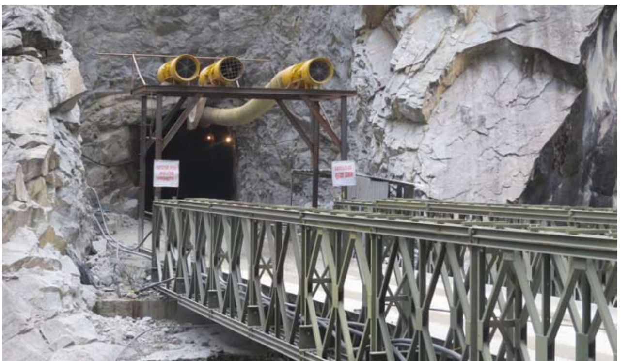
तिव्रगतिमा निर्माण : म्याग्दीको नारच्याडमा निर्माणधिन अवस्थामा रहेको ४२ मेगावाट क्षमताको मिस्त्री खोला जलविद्युत आयोजना । आयोजनाको अहिले बाँधस्थलबाट सुरुङ खन्ने काम तिव्ररूपमा हुँदै छ । तस्विर ठाकुरप्रसाद आचार्य
