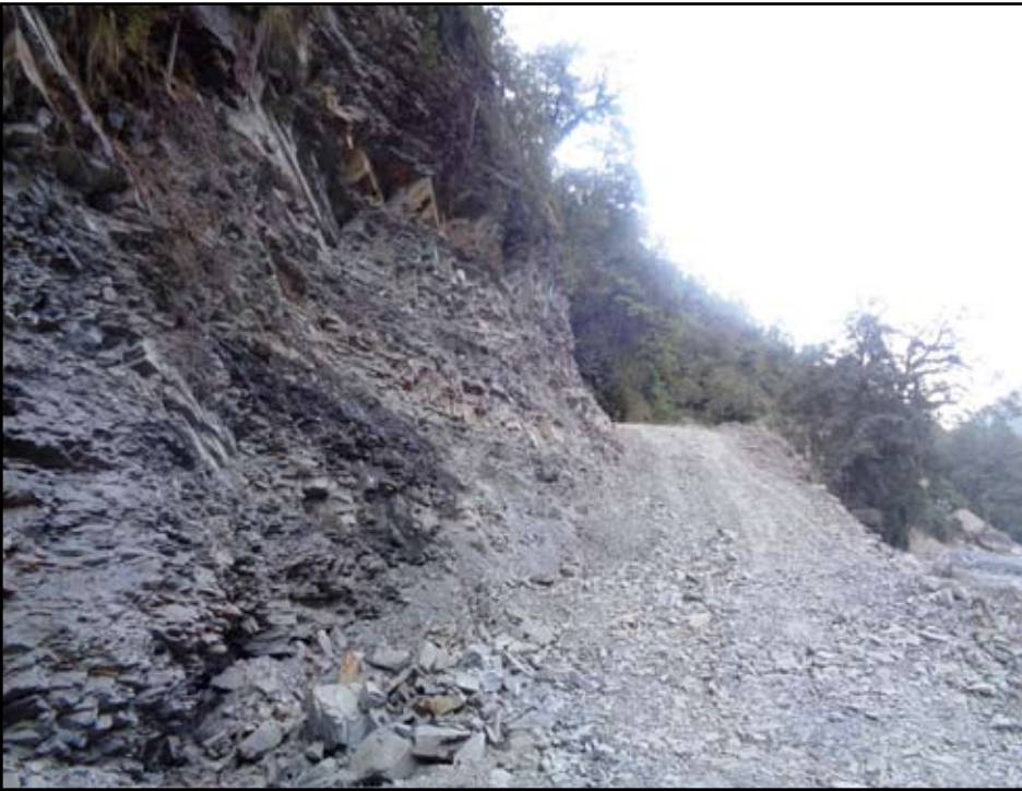
फुलबारीदेखि ओखरबोट जोड्ने सडकको महभिर तलको क्षेत्रमा हालै निर्माण गरिएको सडकको नयाँ ट्यूक ।
