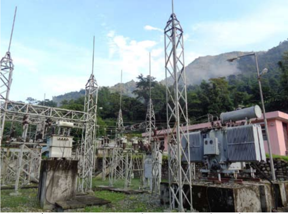
पर्वतको माझफाँटमा रहेको ३३ र ११ केभी क्षमताको मिलनचोक सब स्टेशन । तस्विर : नवविकल्प
